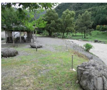
バーベキュー場の利用者が、増水した川に転落を防止するための人止柵を設置
